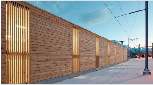
Einstellhalle für Bahnwagen - Samedan (CH - GR) Brasser Architekten
