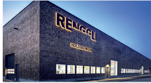
Holzbaubau-/Produktionswerk - Schötz (CH - GR) Renggli AG
